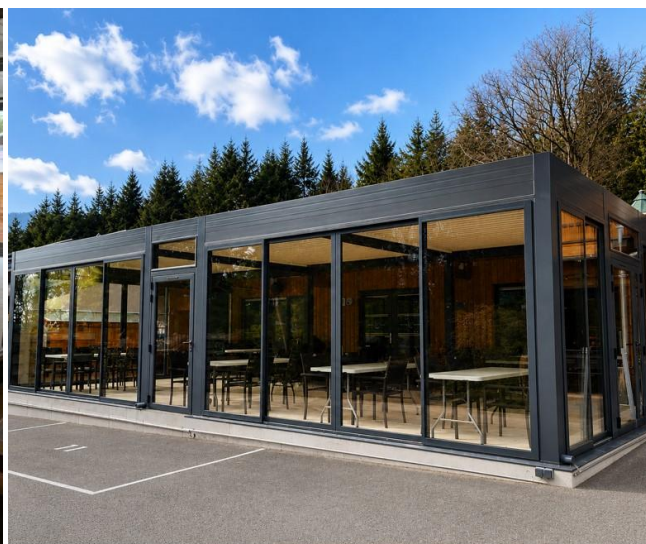
Vue de l'extérieur.
